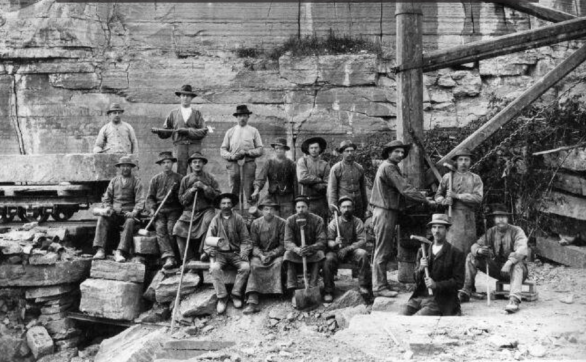
Bilden på arbetslaget i Stora Lannagruvan är från ca 1910–1915. Längst fram med slägga sitter Karl Nilsson på Fnuggen. Denna typ av lyftkran användes till långt in på 1940-talet, men motoriserades under Skifferverkets sista tid. Man bryter troligen sten för bearbetning, se trallan till vänster. Foto: Västernärkes hembygdsförenings bildarkiv
